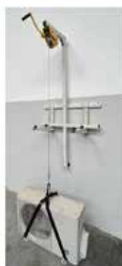
7. Imbracatura della macchina Utilizzare la cinghia in dotazione per imbragare la macchina clima e agganciare la cinghia al gancio del verricello.
