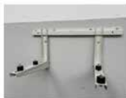
1. Installazione staffa a muro Fissare la staffa clima alla parete, tassellando sia la traversa orizzontale sia ciascun braccio di supporto, assicurandosi che la struttura sia stabile e perfettamente in bolla.
